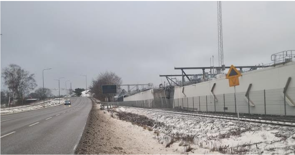
Figur 23. Vägkant mot Gryaabs mark, fotad mot väst
